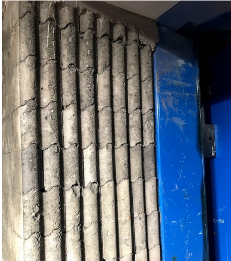
Figur 38: Byggekløsser ved bygging av stråleterapirom ved Sahlgrenska sykehus i Gøteborg. Foto: Sykehusbygg HF
