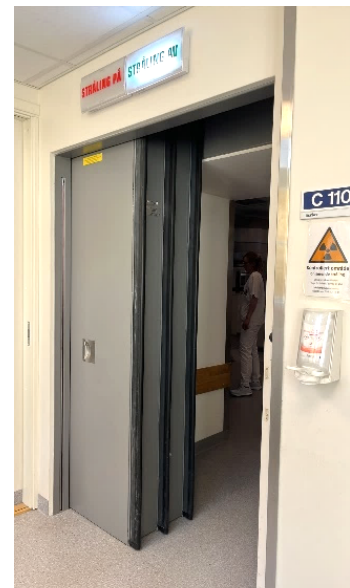
Figur 4141: Skjermingsdør til strålebehandlingsrom, Radiumhospitalet. Foto: Sykehusbygg HF
