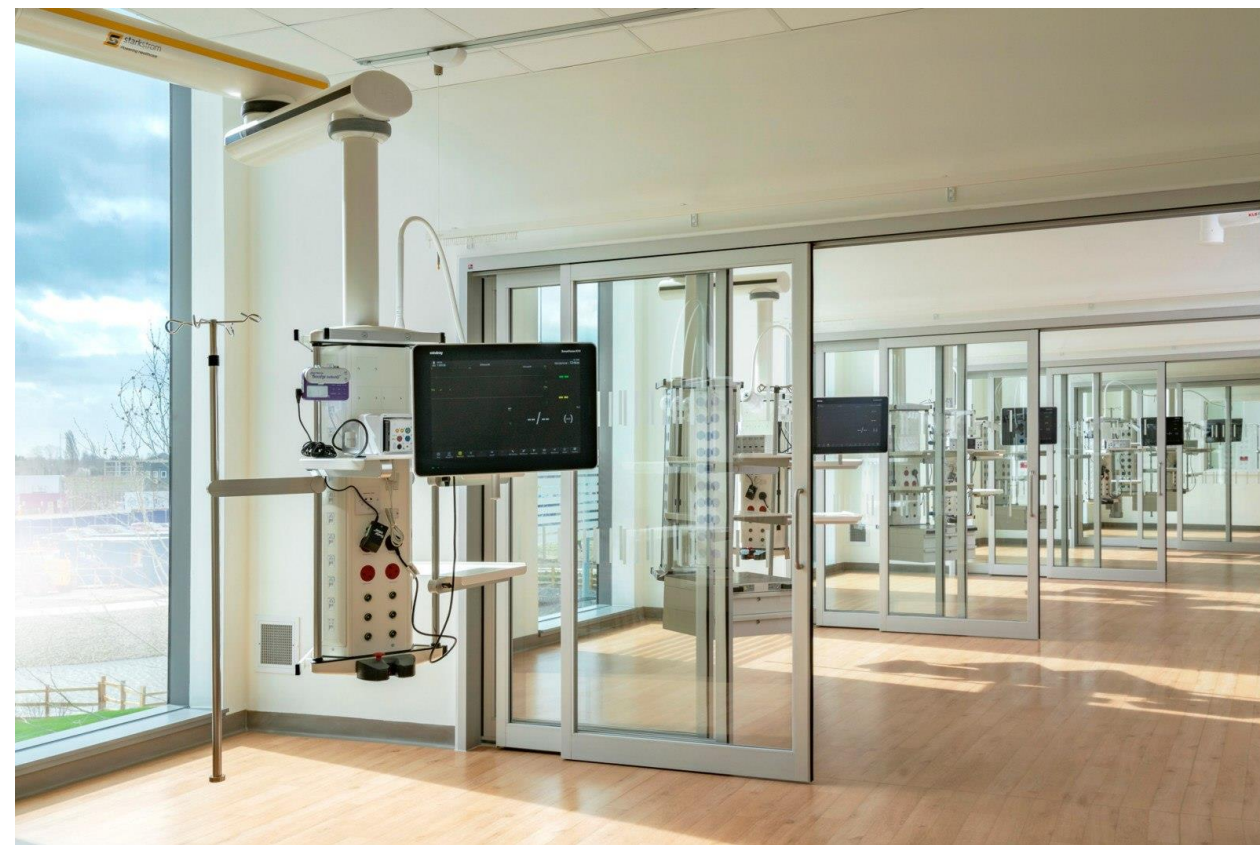
Fri sikt mellom korridor og pasient
