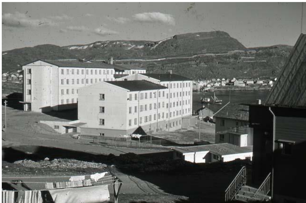
Figur 6-43: Dagens Hammerfest sykehus på Fuglenes fotografert ca. 1960
