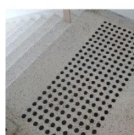
Farefelt foran Øverste trinn i alle Trapper. Lumiånskontrast Ihht tek 17.
