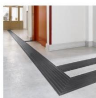
Ledelinje for å føre frem til viktige funksjoner i sengeposter - på vinylgulv
