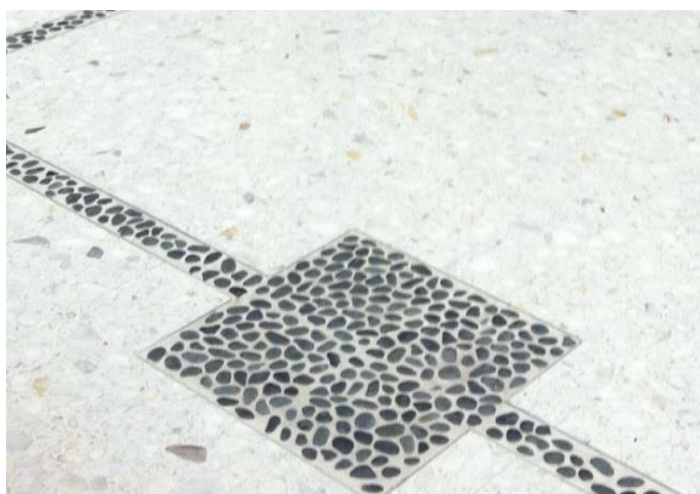
Figur 70 Spesiallagede ledelinjer som på St. Olavs hospital, med mørke steiner på lyst belegg eller med standard elementer, her vist med lysende punkter på mørkere bunn. Luminanskontrast skal være på 0,8.
