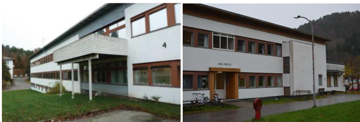
Bilde 2: Bygg 4 og bygg 6, akuttmottak
