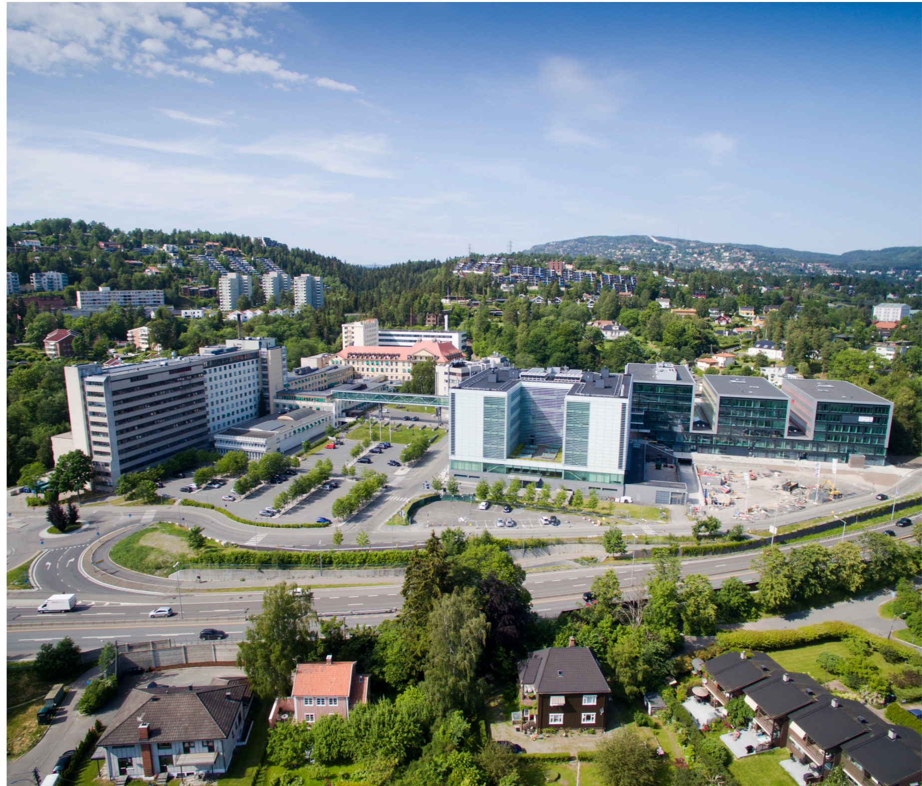
Figur 20: Luftfoto fra sør, før rivearbeidene startet
