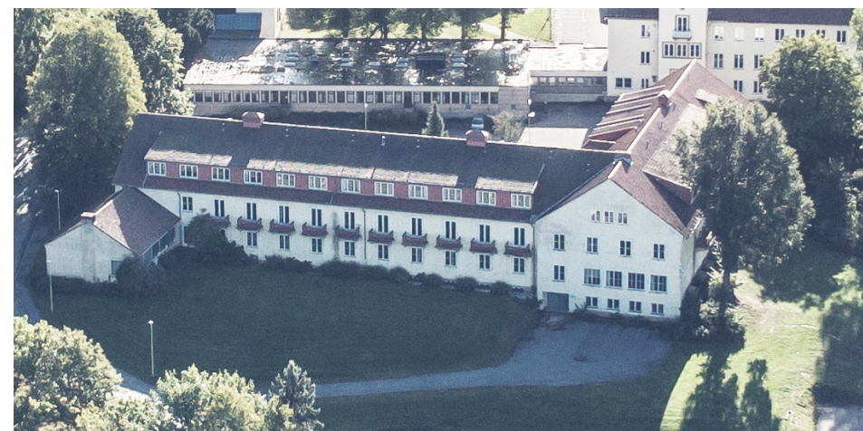
Bygg 60 - Eksteriør mot vest 2018
