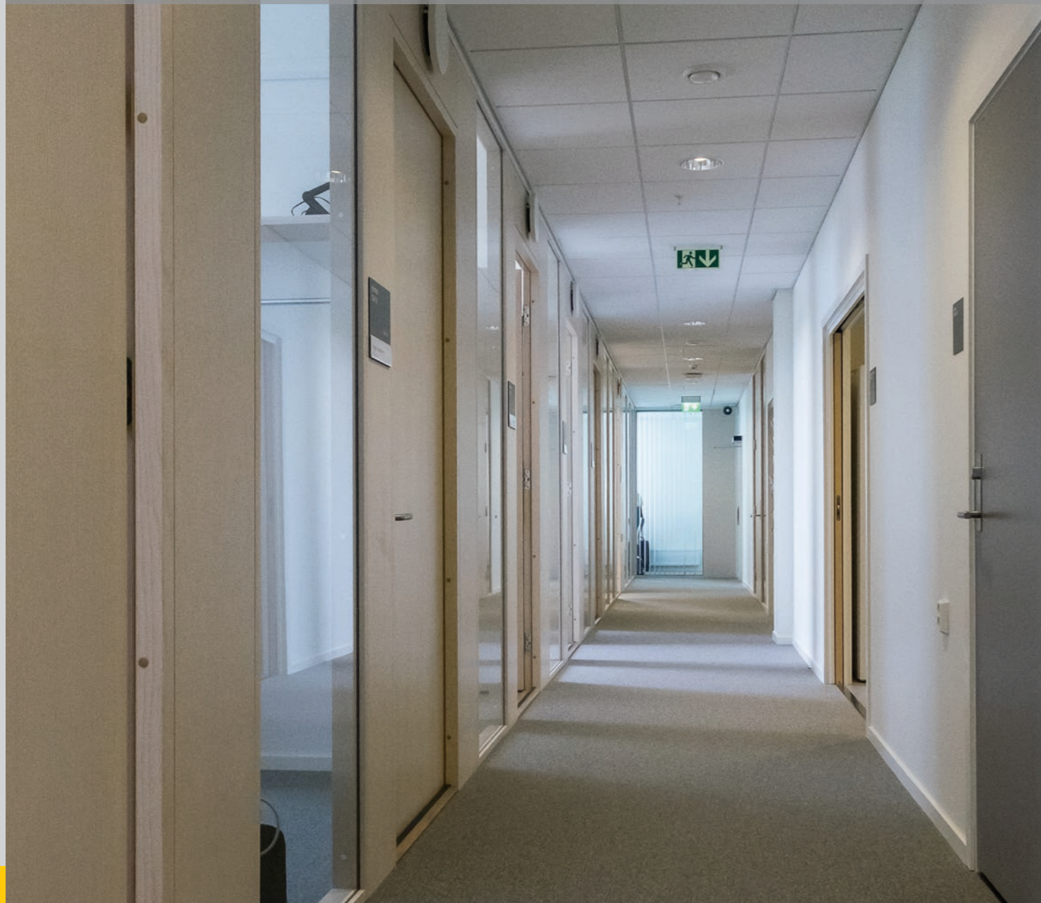
Gode lyskilder i enden av korridor.
