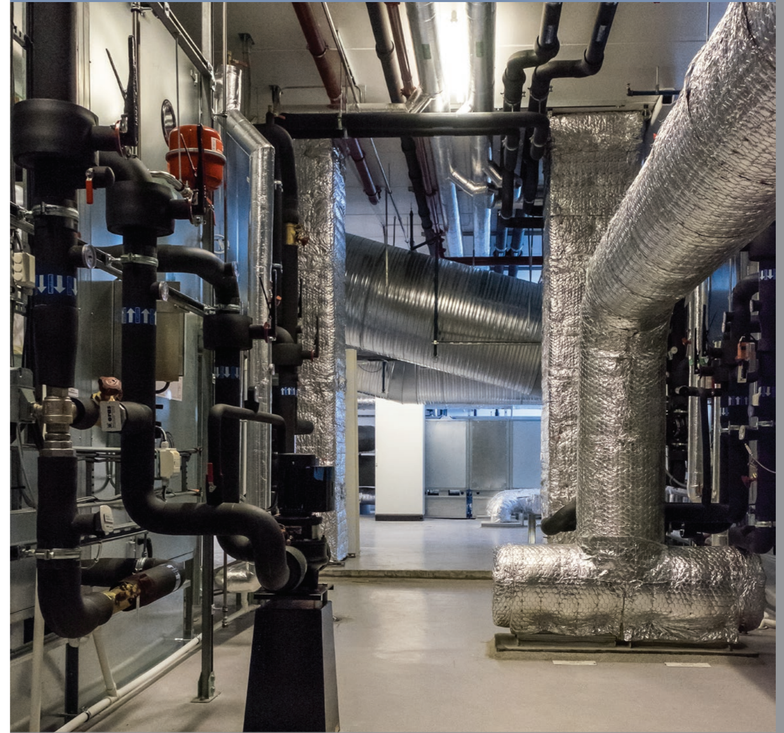
9. etasje i K-fløy er for det meste forbeholdt tekniske rom.
