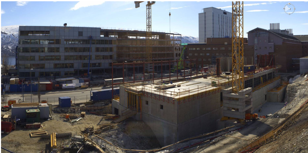
Byggeområdet ved UNN Breivika 30. april 2016
