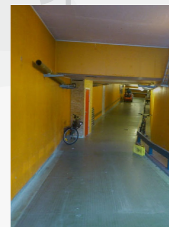
Bilde fra eksist. kulvert
