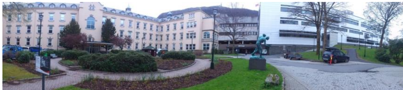
Bilde fra hovedinngangen til gamlebovebygg og Sentralblokken
