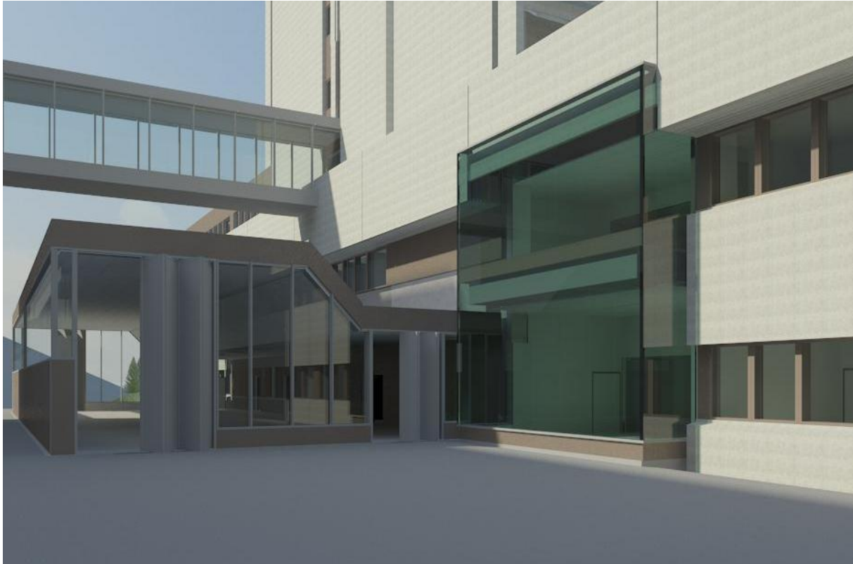
Ny karnapp på nordsiden av ambulanshall over to etasjer
