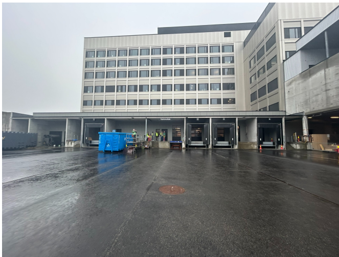
Varemottak Nye Stavanger Universitetssykehus, Foto: Sykehusbygg
