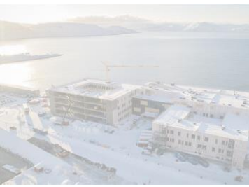
Nye Hammerfest sykehus
