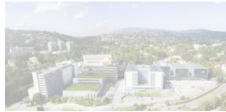
Nytt klinikk og protonbygg, Radiumhospitalet
