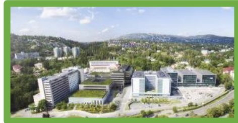
Nytt klinikk og protonbygg, Radiumhospitalet
