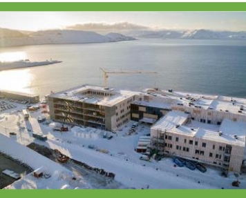
Nye Hammerfest sykehus
