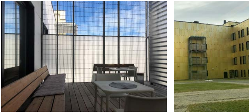
Figur 43: Sikrede ballkonger i tilknytning til skjermingsenbeter. Foto: Sykehusbygg HF
