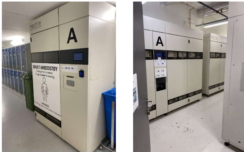
FIGUR 46 Tøyautomater til personaltøy, inn- og utlevering, Bærum sykehus, Vestre Viken HF, Foto: Sykehusbygg HF
