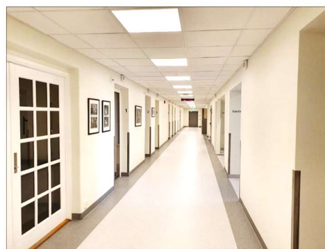
FIGUR 30 Korridor Kreftavdelingen Bærum sykehus, Vestre Viken HF. Foto: Sykehusbygg HF
