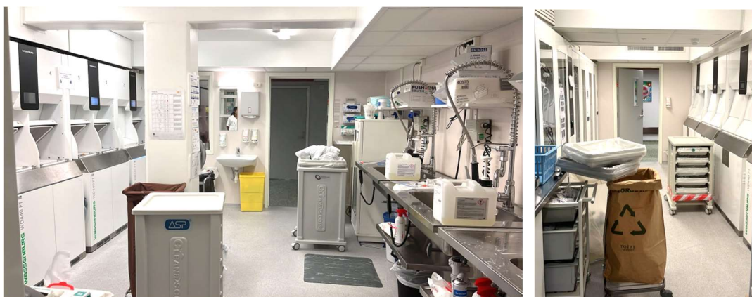
FIGUR 106 Desinfeksjonsrommene er delt i to i henholdsvis til uren og ren side, Medisinsk poliklinikk, Bærum sykehus. Stålvaskene i høyre bilde er justerbare og bemerk også myke gulvmatter. Foto Sykehusbygg HF
