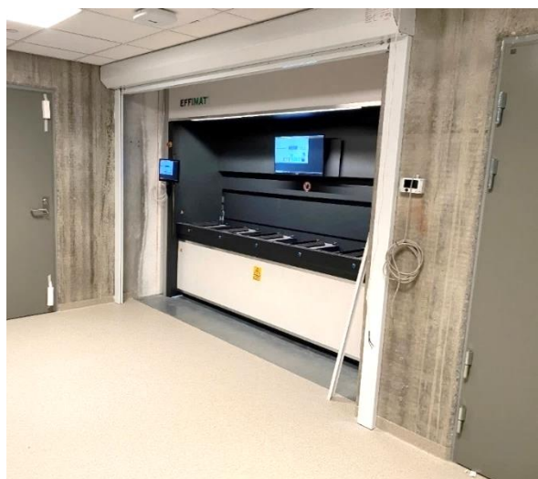
Figur 3.27 Vareheis Effimat plukkstasjon i forrom på etasjeplan, Foto: Stian Henriksen, Nye SUS
