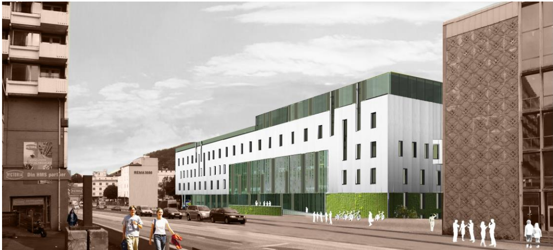
Fra Fjøsangerveien, inngang fra bybanen.
