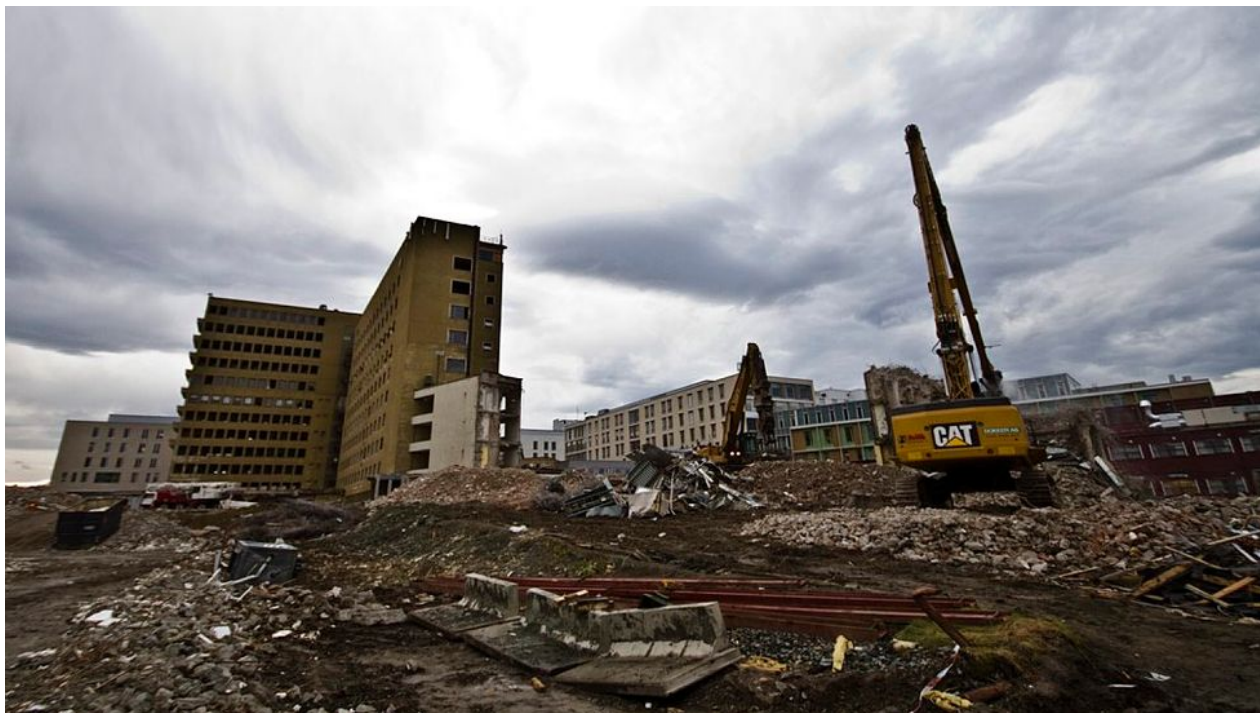
Figur 2: Riving av den gamle høyblokka St.Olavs hospital
