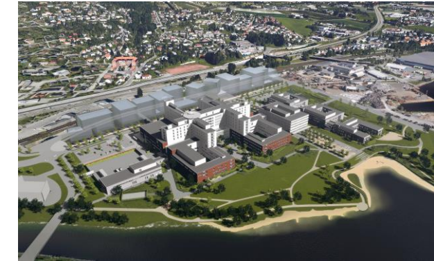
Nytt sykehus Drammen
