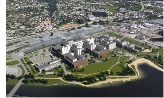
Nytt sykehus Drammen
